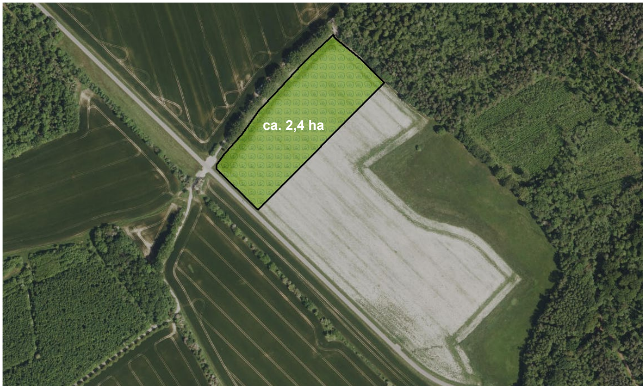
Abb. 21 Lage und Ausdehnung der geplanten Ersatzfläche (schwarze Umrandung) im Bereich des Flurstückes 903, Gemarkung Störmthal ©Geoportal Sachsen ©BCE
