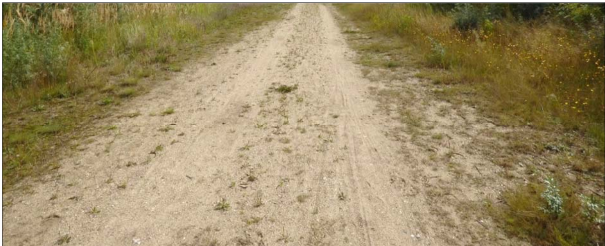
Abb. 28: unbefestigter Sandweg parallel zum Ufer
