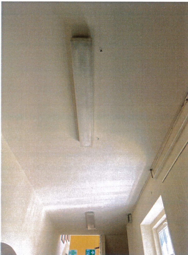
Erneuerung Rettungswegebeleuchtung und sicherheitstechnische Anlage
