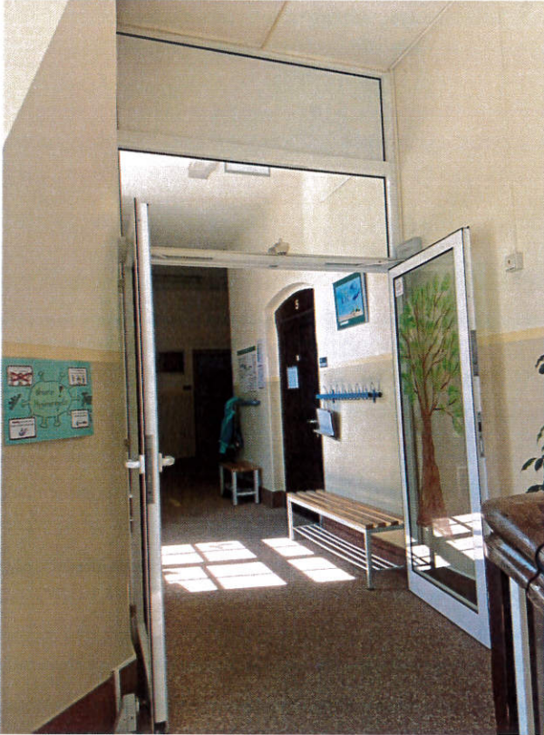
Erneuerung Flure und Treppenhäuser
