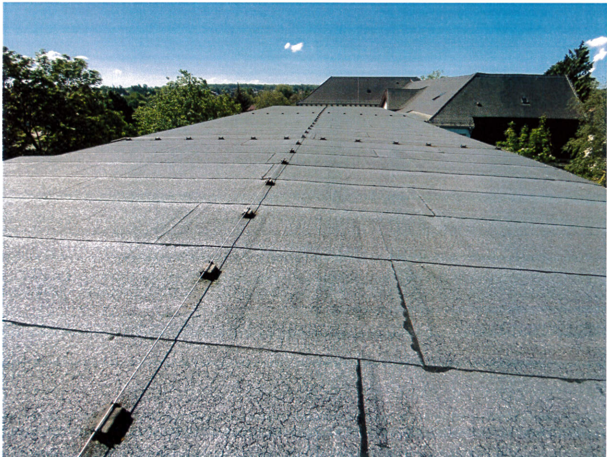
Zu erneuernde Dachdichtung – Aufstellbereich der PV Anlage zur Eigenstromerzeugung
