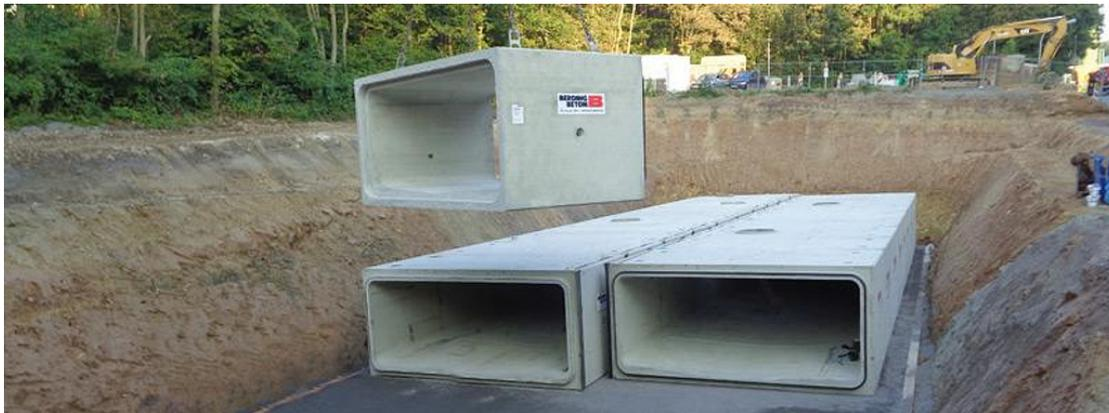
**Abbildung 5: Beispiel eines Rechteckkanals als Retentionsraum für Regenwasser (Quelle: Berding Beton)**
