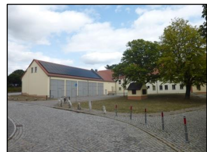
Kommunale Photovoltaikanlage (Quelle: STEG)
