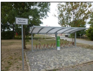
Ladestation im Rittergut (Quelle: STEG)
