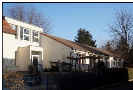
Erweiterungen Treppenhaus (2004), Anbau (1989) (Quelle: Gemeinde)
