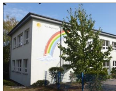
Schulgebäude und Hort (Anbau 1970) (Quelle: STEG)
