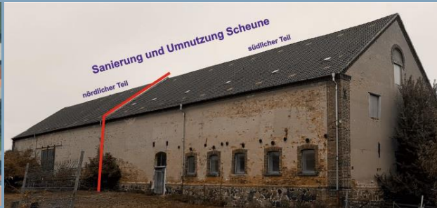
Ansicht von Westen (Quelle: Gemeinde Großpösna/Bauplanung Wildeis, 2018)
