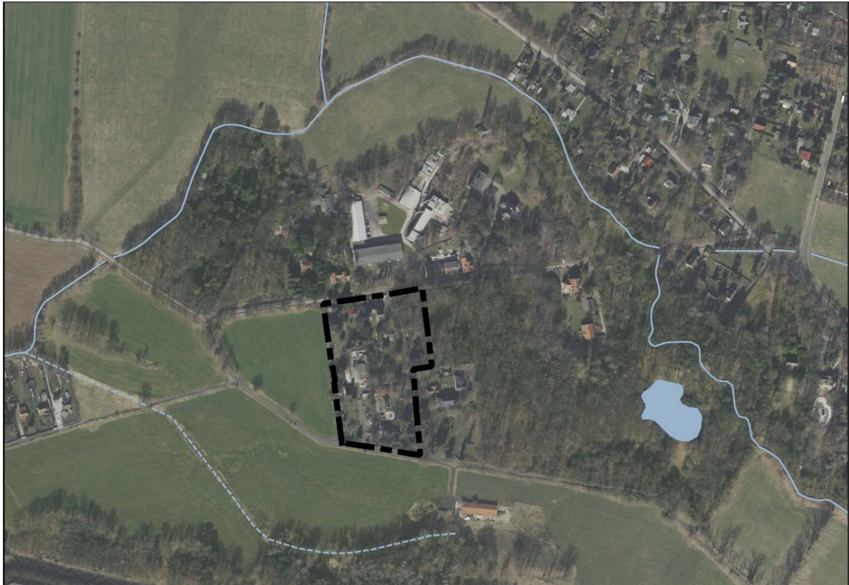
Abb. 4 Lage der Gewässer im Umfeld des Geltungsbereichs (durchgezogene blaue Linie: „Faule Parthe“, gestrichelte blaue Linie: Emtwässerungsgraben)
