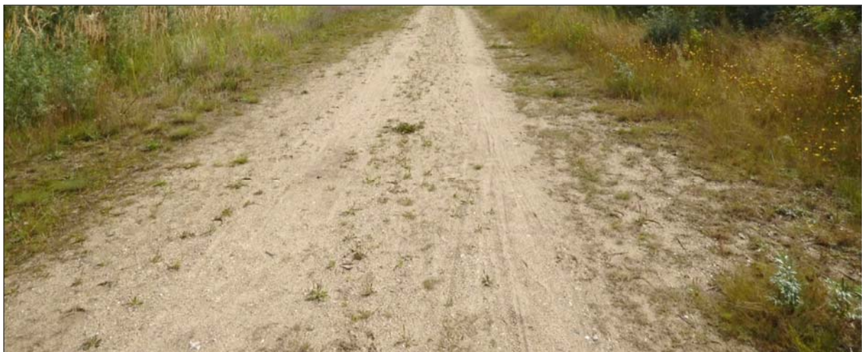
Abb. 28: unbefestigter Sandweg parallel zum Ufer
