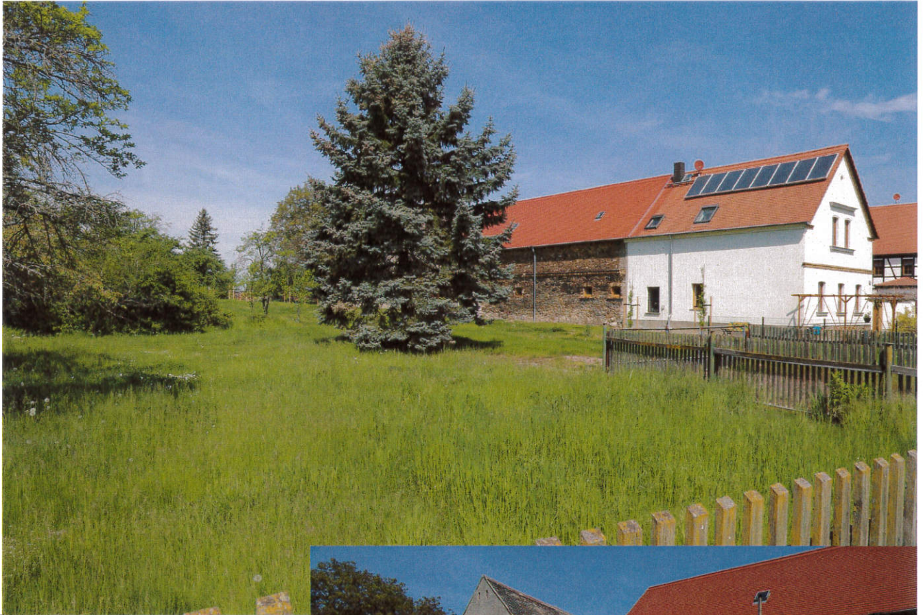
Blick nach Nordwesten auf das Baufeld und zu Haus 31
