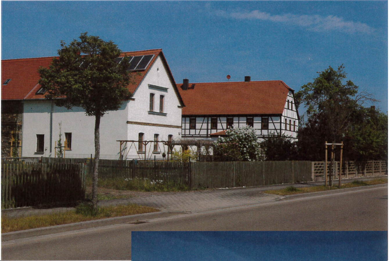
Blick nach Norden zu den Häusern 31 und 33
