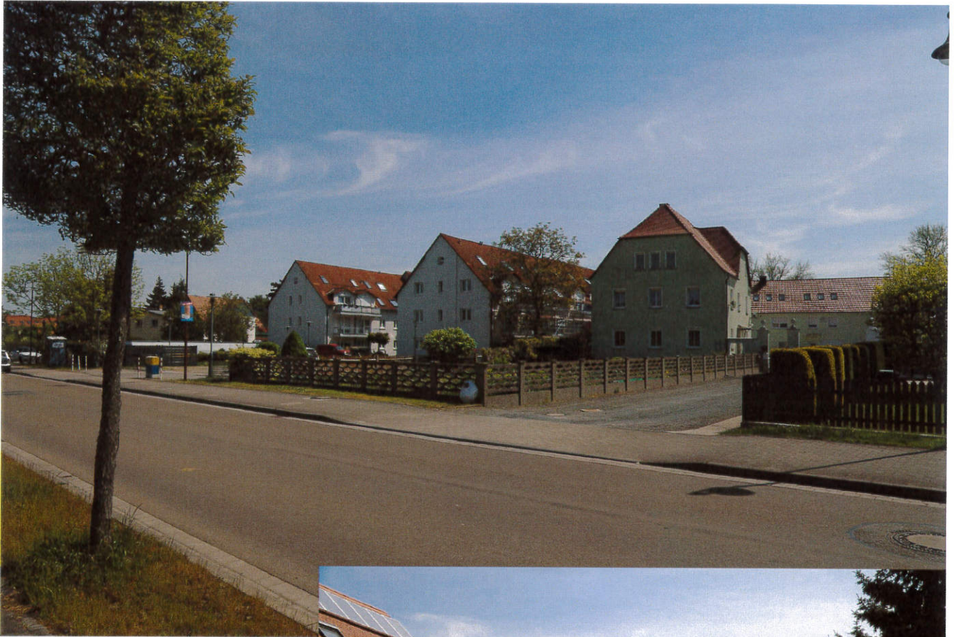
Blick nach Osten zur gegenüberliegenden Bebauung (Häuser 38 und 40)
