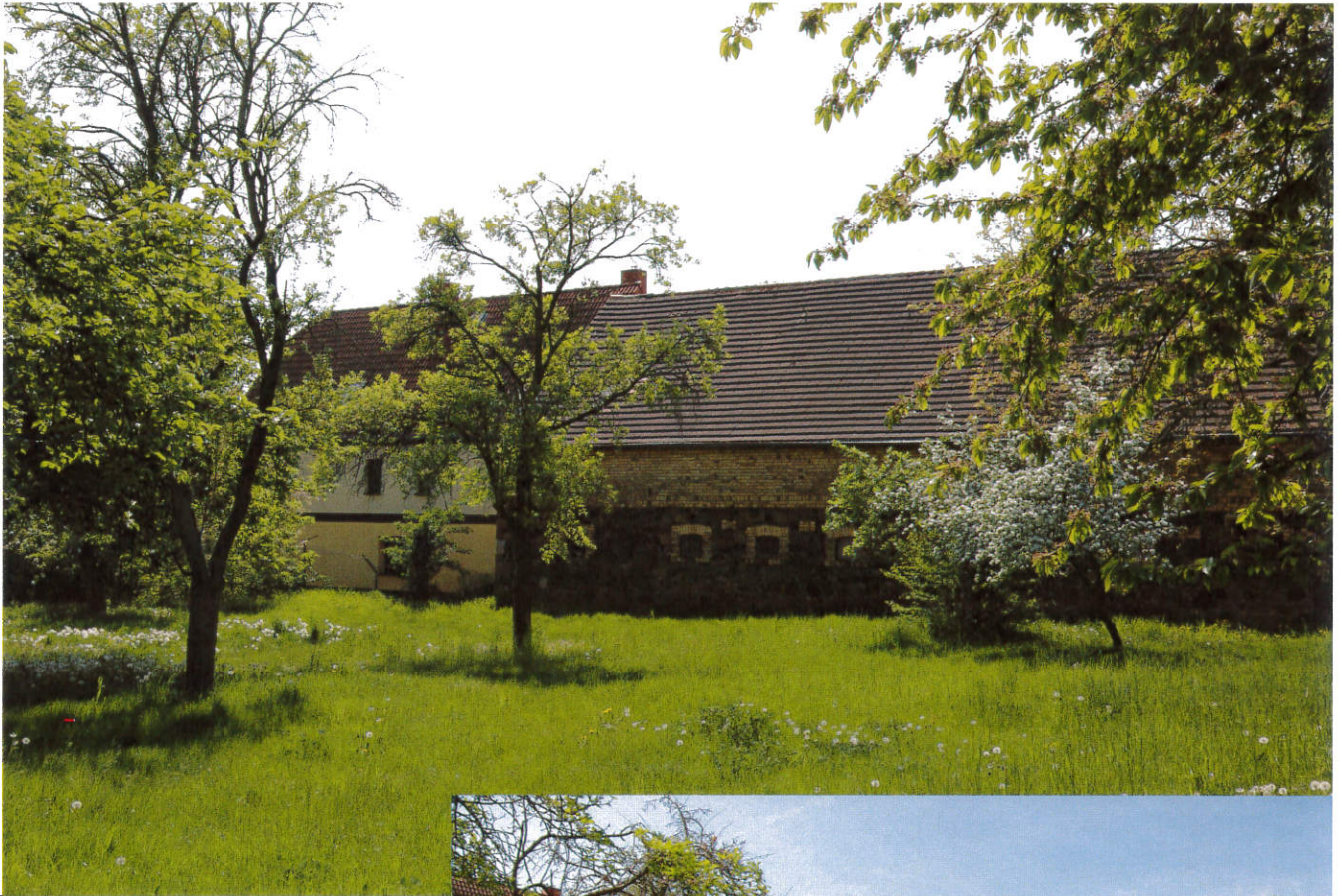
Haus 27, Blick nach Süden (oben) und nach Südwesten (rechts)
