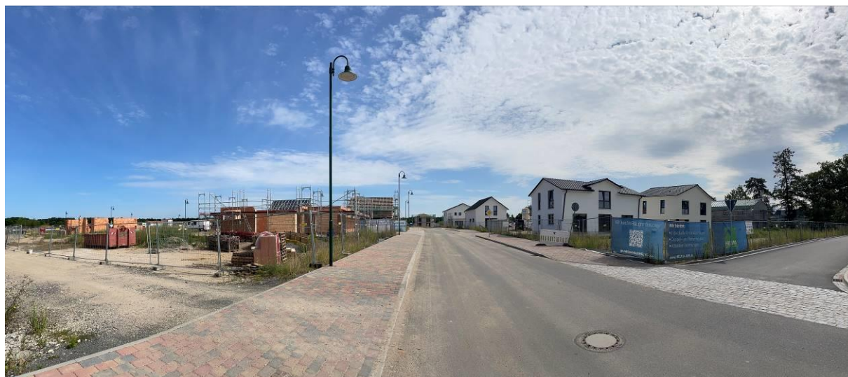
Erster Bauabschnitt Grünstadt Naunhof, komplett erschlossen, erste Wohngebäude fast fertiggestellt
