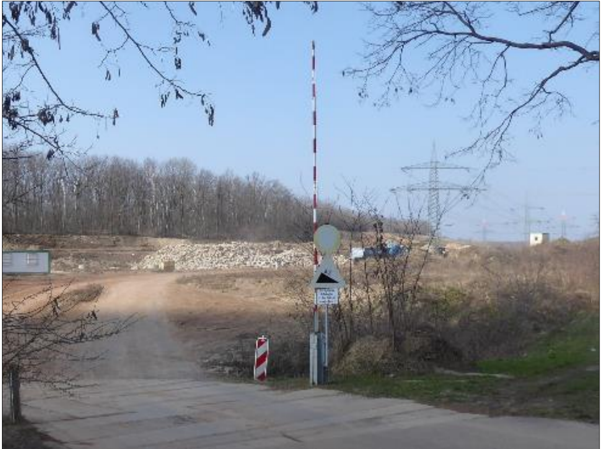
Abb. 6: Abgrabung, Auffüllung im Bereich des ehem. Tagebaus, 03/2021
