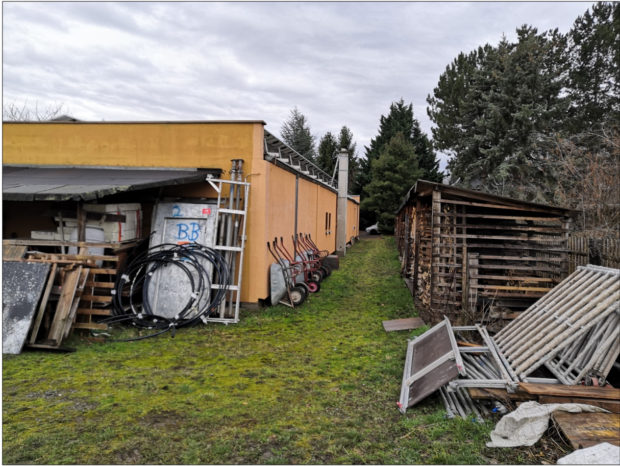
Abb. 6: Rückseite des Bestandsgebäudes (Aufnahmedatum: 06.03.2020)
