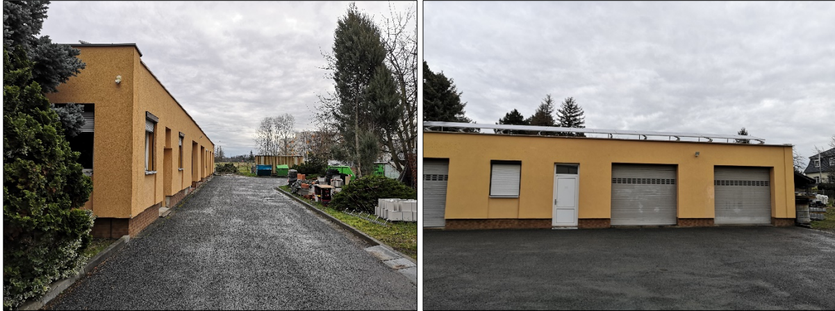
Abb. 4: Bestandsgebäude der Beuchaer Bau GmbH im westlichen Teil des Plangebietes
