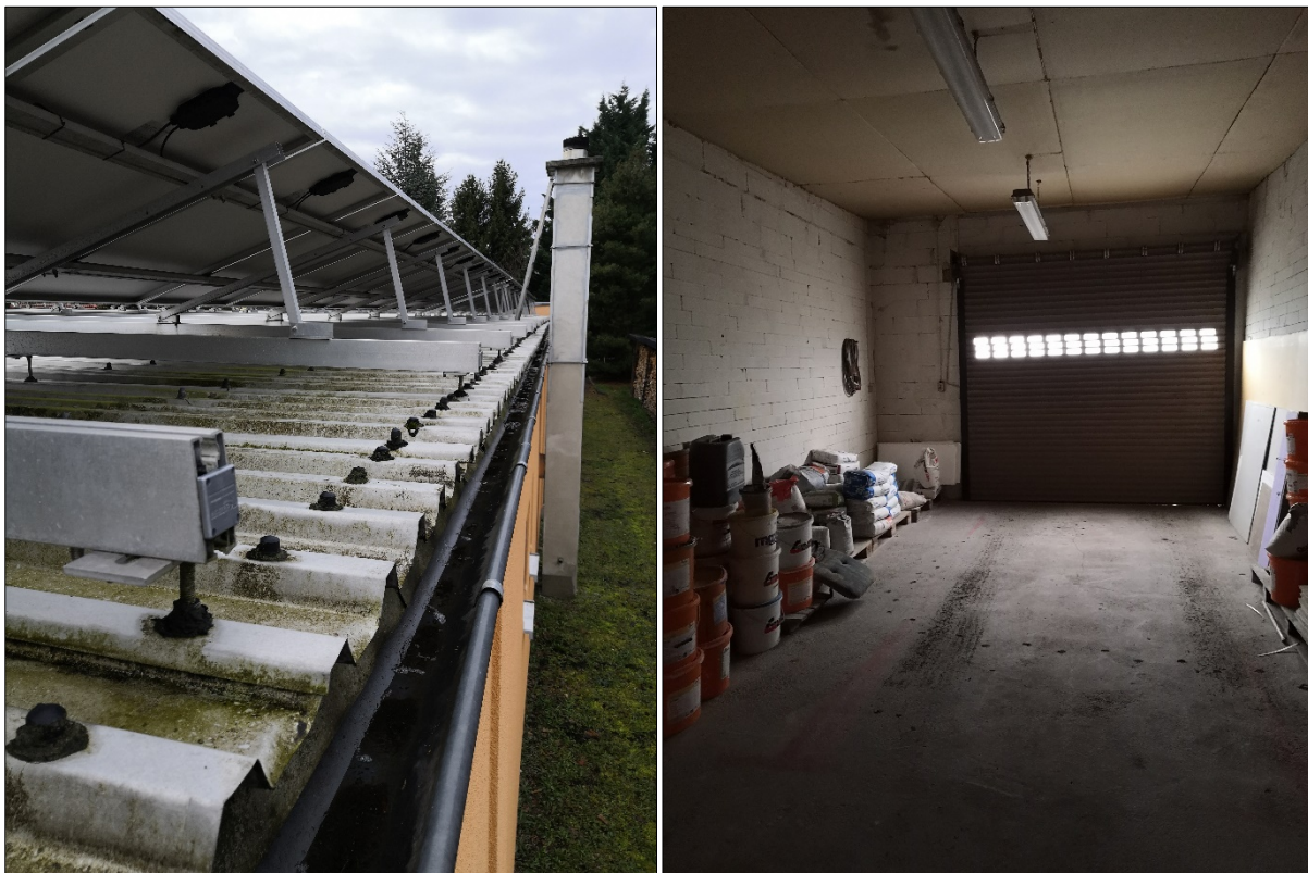
Abb. 5: Photovoltaikanlage auf Wellblechdach (links) und Innenraum der Garage des Bestandsgebäudes (rechts) (Aufnahmedatum: 06.03.2020)
